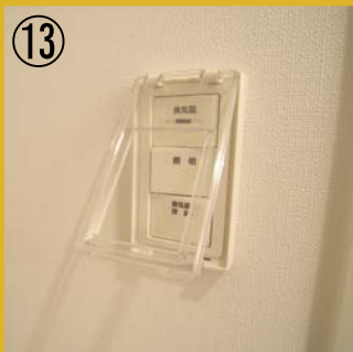
【24時間換気】 24時間換気システムでシックハウスを防止します。
