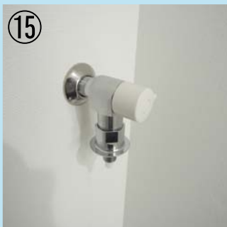
【オートストップ付き吐水口】 洗濯機の万一の漏水事故を防ぎます。
